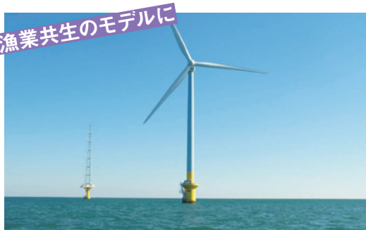
2013年に設置された洋上風車。(出典：東京電力リニューアブルパワー)
